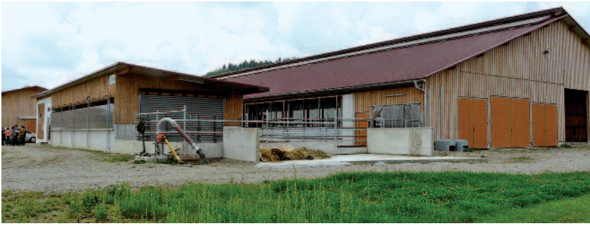
Aussiedlerhof der Denkinger-GbR in Warthausen-Röhrwangen mit Boxenlaufstall (83 Liegeboxen), separatem Melkhaus, Kälberstall und offener Güllegrube.
